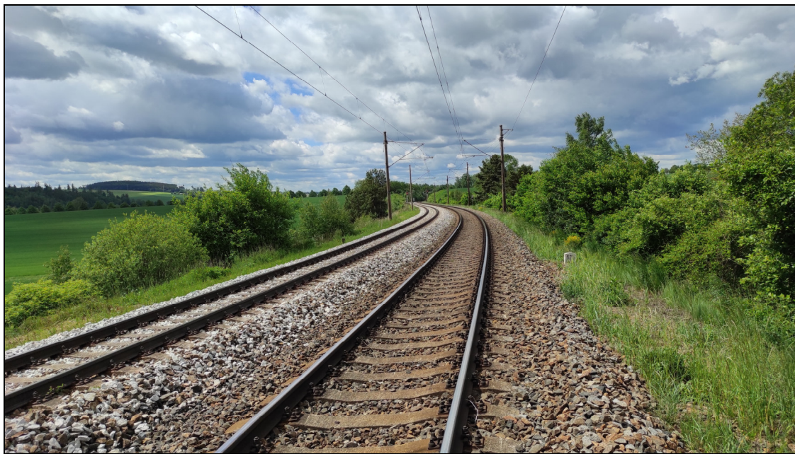
Obr. 2: Železniční trať východně od zastávky Hamry nad Sázavou
